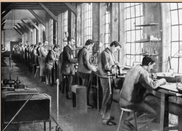
Abbildung: Brunsviga-Montage-Saal Nr. 1
