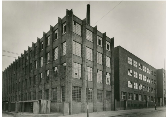
Abbildung 16: Brunsviga Fabrikgebäude, wie sie häufig in Prospekten zu finden sind (#B_051)
