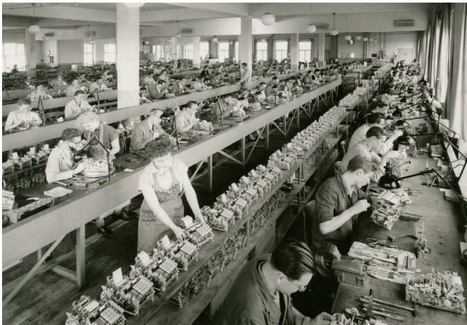
Abbildung 14: Blick in die Brunsviga-Fertigung (#B_002)
